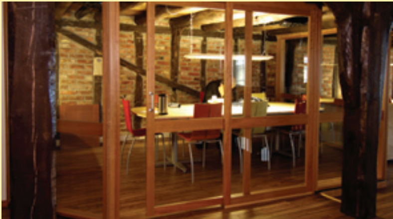
Skyvedør bruk i rehabilitering av gammelt sjøhus.
