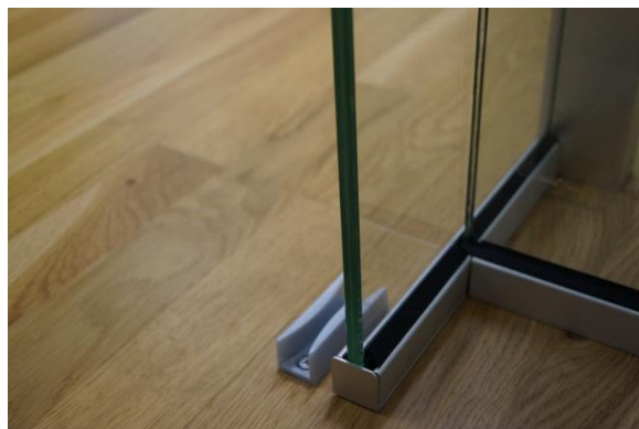
Detalj glasskillevegg mot frontvegg
